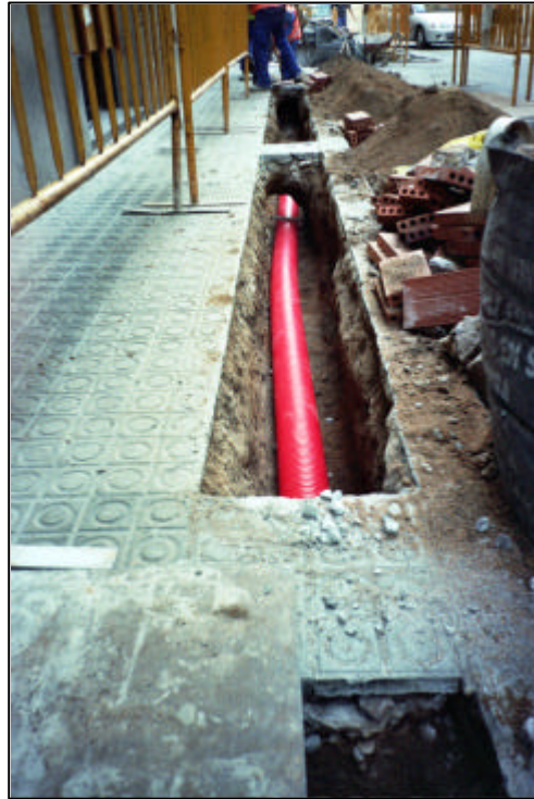
Foto 5: Realització de les feines de cablejat elèctric.
