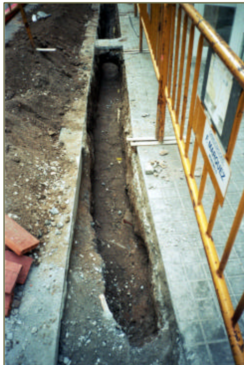
Foto 2: Tram de la rasa excavada
