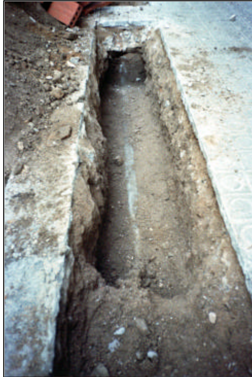
Foto 3: Detall de la rasa on es localitza un servei de gas.
