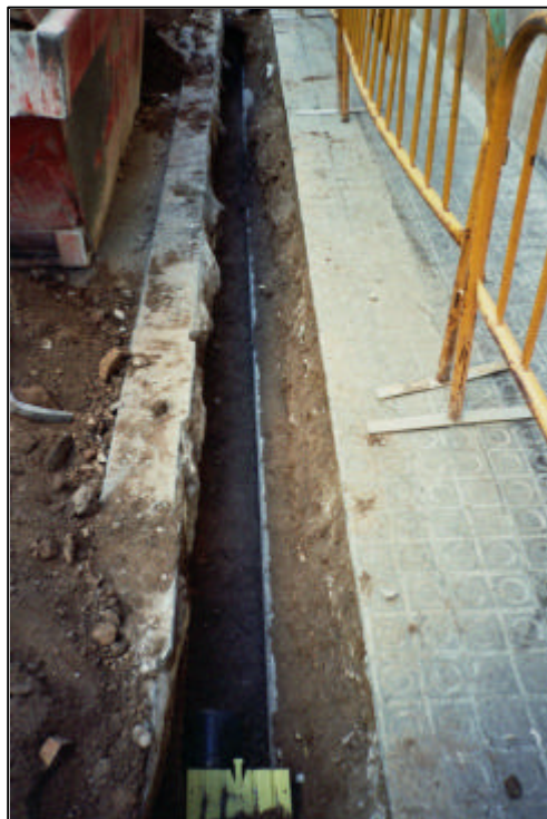
Foto 4: Localització d'un servei antic.
