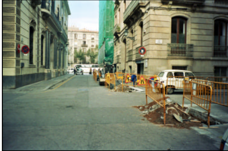
Foto 1: Vista general del carrer Duana amb la rasa realitzada.
